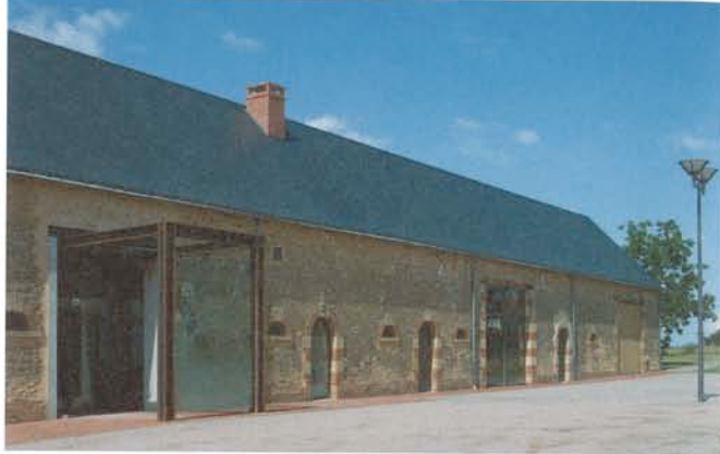
32 ESPACE SOCIOCULTUREL LA LONGÈRE 31, rue du Thuret 72550 Coulans-sur-Gée 2007 Maître d'ouvrage : Communauté de communes des Pays de Loué Maître d'œuvre : Pièces Montées Atelier d'Architecture
