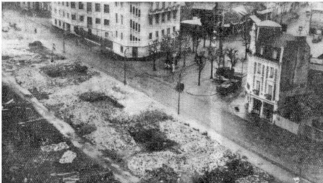
Vue sur l'immeuble qui donnait sur une placette au moment des travaux de déconstruction de l'ancienne gare du tramway.
