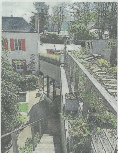
La toiture terrasse et son escalier.
