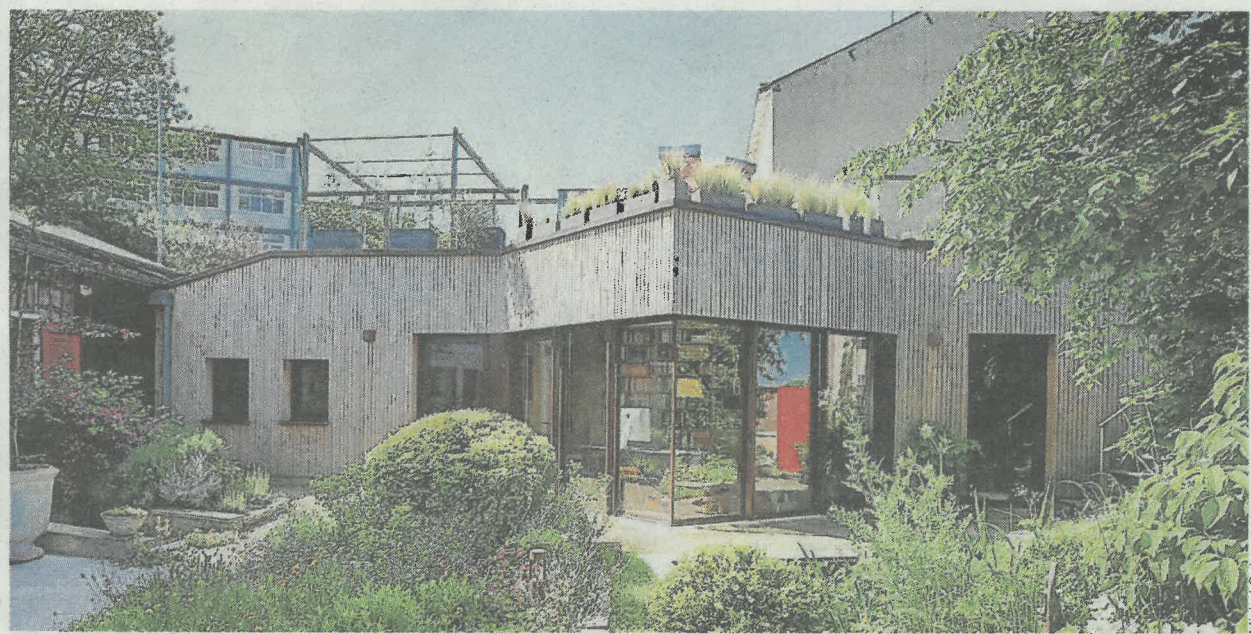
L'extension, construite au nord, s'ouvre sur le jardin. Sur son toit, un deuxième jardin a été aménagé.
